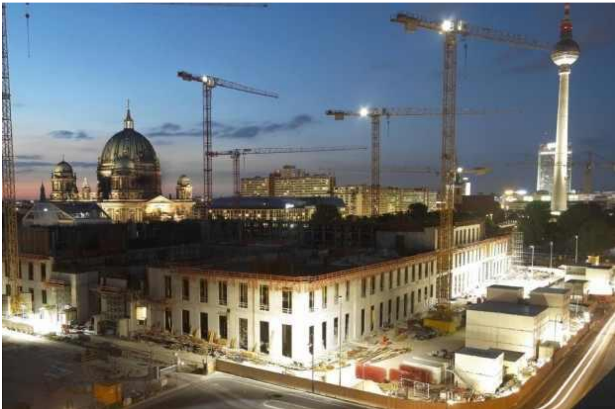
Die Baustelle des Humboldtforums in Berlins historischer Mitte
