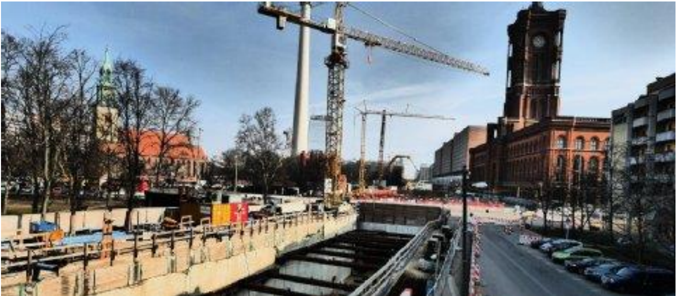
Vor dem Roten Rathaus fällt derzeit vor allem die Baustelle zum Bau der U 5 auf. Doch was soll eigentlich aus dem Rathausforum werden? Foto: imago/Jürgen Ritter
